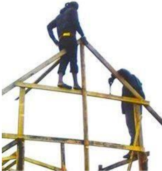
Figure 3 : L'église en cours de construction, photo tirée de la page Facebook L'Auberge des Migrants , 29 octobre 2016.
